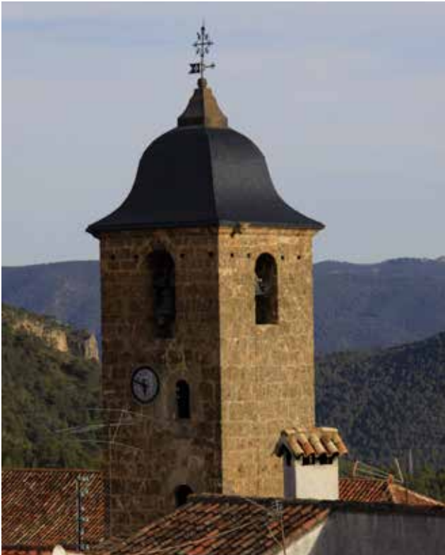
^ Torre de la Iglesia de la Asunción
