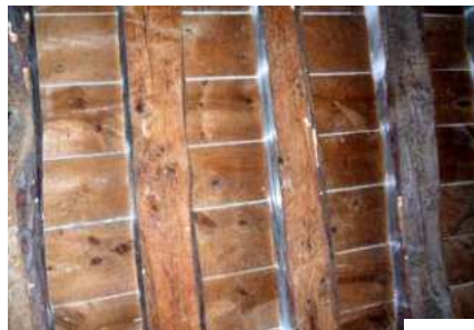
Techumbres realizadas con cañas y con tablones de madera, y dos tipos diferentes de revoltones, con rollizos y con vigas de madera.
